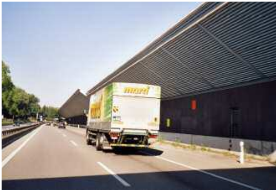
Abb. 2: Autobahn A6 mit Lärmschutzmassnahmen
