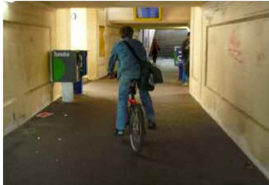
Abb. 36: Die Personenunterführung soll saniert werden
