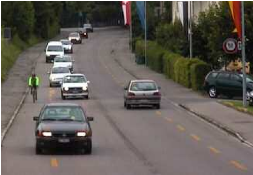
Abb. 29: Kernfahrbahn auf der Thunstrasse
